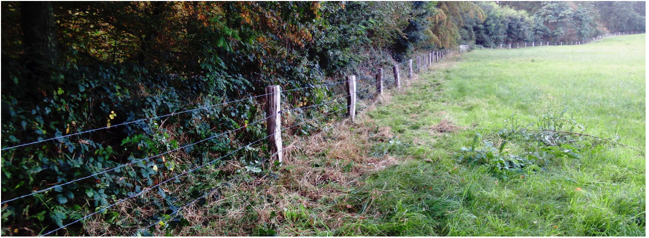
Kollmoorfläche - Entfernung der Brombeertriebe zur Vorbereitung der Zaunarbeiten
