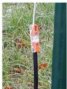
Mit diesen wasserfesten Verbindungshilfen ist ein gerissener Draht mit wenigen Handgriffen wieder dauerhaft und sicher verbunden. Wir setzen sie mittlerweile bei allen Zaunkontrollen ein. Es erspart ein lästiges, zeitintensiveres Neueinbinden und Spannen einer Bruchstelle.
