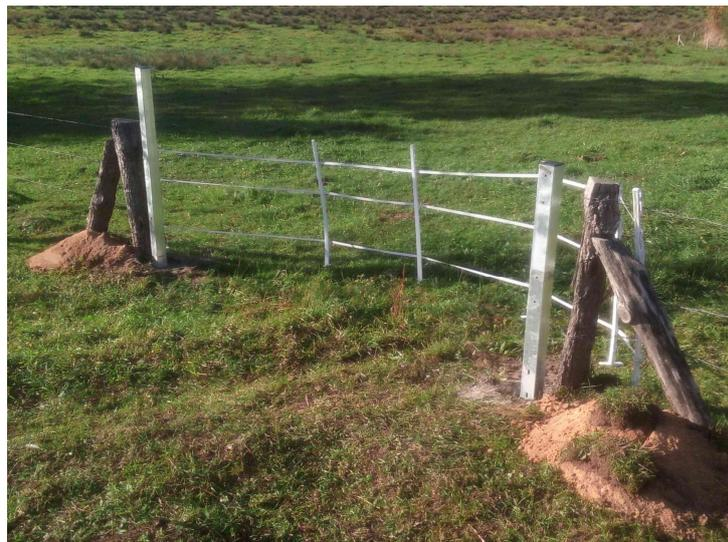
Hier auf den Bildern sieht man den Einbau der Pfosten für die Tore am Stammplatz. Das große Tor für die Transporte auf den Winterflächenteil sowie das kleine Tor Nähe Fanggatter. Beide Öffnungen wurden mit Mobilzäunen bis zum Abschluss der weiteren Arbeiten gesichert
